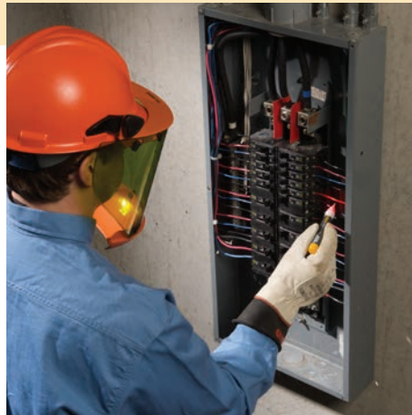
Einsatz an Schalttafeln
