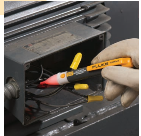
Prüfungen an Verteilerkästen
